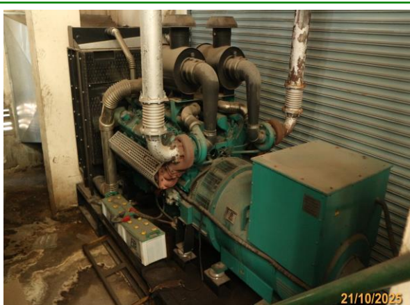
รูปที่ 3-48 Generator phase 2 water plant
