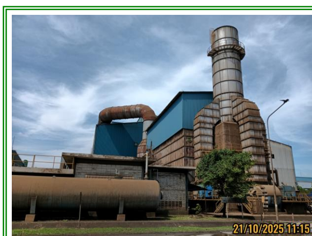
รูปที่ 3-3 ระบบดักฝุ่นแบบ Fume Plant
