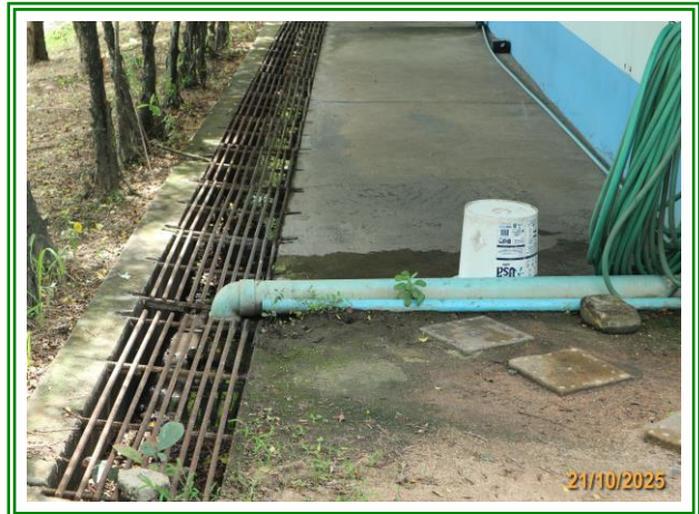
รูปที่ 3-40 รางระบายน้ำบริเวณโรงอาหารที่เป็นท่อพีวีซี (PVC)
